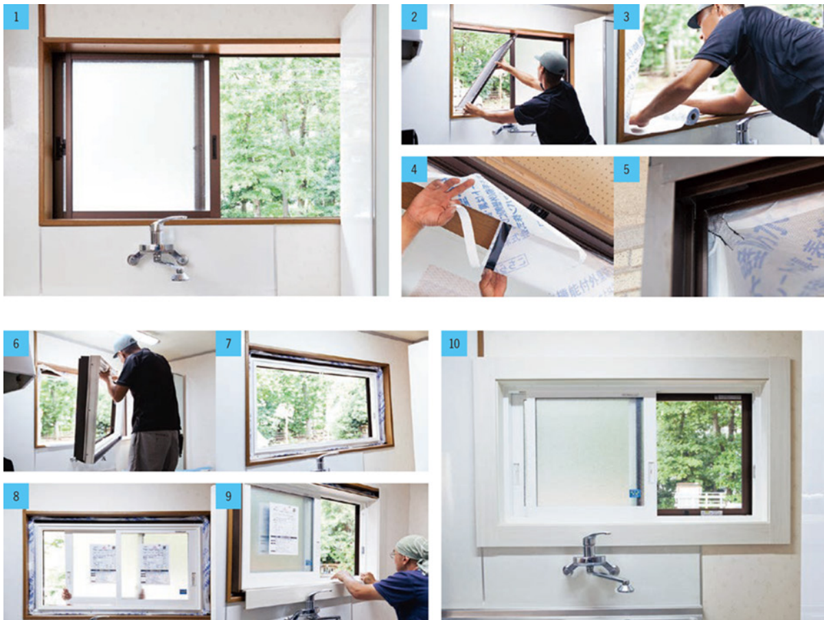
「かんたん マドリモ」リフォーム施工の流れ
