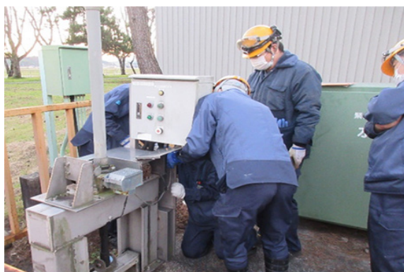
東北製造所 水門手動動作訓練
