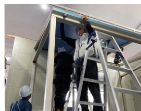
2023年9月に九州製造所内に新設した「DO SPACE 九州」
