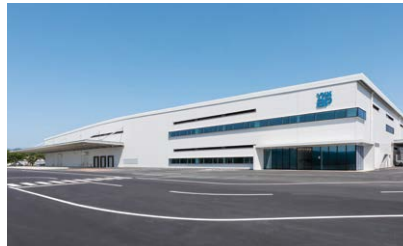
2023年に完成した埼玉工場の新建屋
