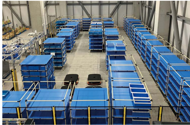
2023年10月、埼玉県加須市に物流送拠点「首都圏DC」を開設(写真は内観)し、首都圏エリアに向けた住宅用商品の供給体制を強化。在庫管理によるトラックドライバーの夜間・長距離輸送の回数削減などでドライバーへの負荷低減も見込む
