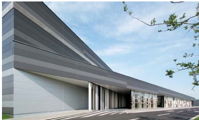
2011年に操業を開始した埼玉窓工場
