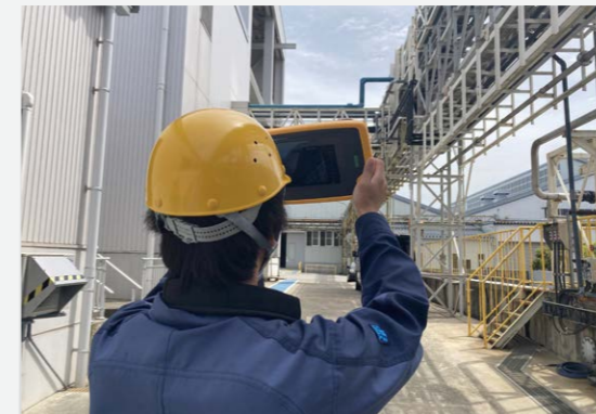
黒部製造所で省エネ設備を点検する様子
