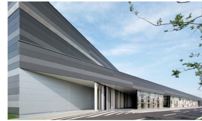
2011年に操業を開始した埼玉窓工場
