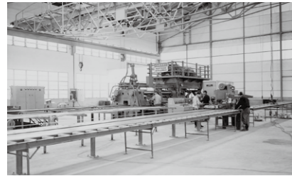
1959年に設置したアルミ押出機
