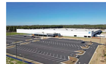
2023年に米国で操業を開始した樹脂窓の新工場
