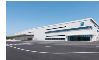
2023年に完成した埼玉工場の新建屋
