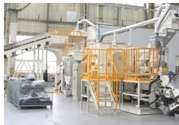
RPF製造設備（黒部越湖製造所）
